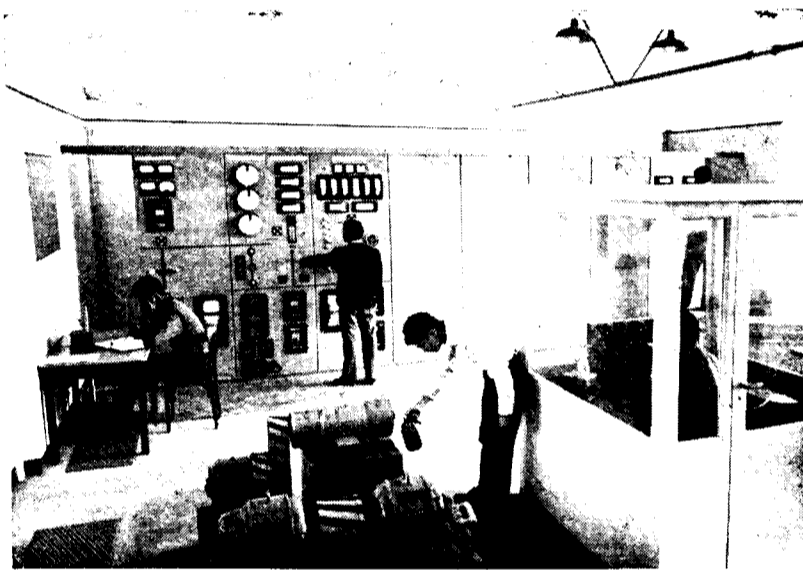
L'équipement pilote dans la salle de mesure et essais d'électricité.
