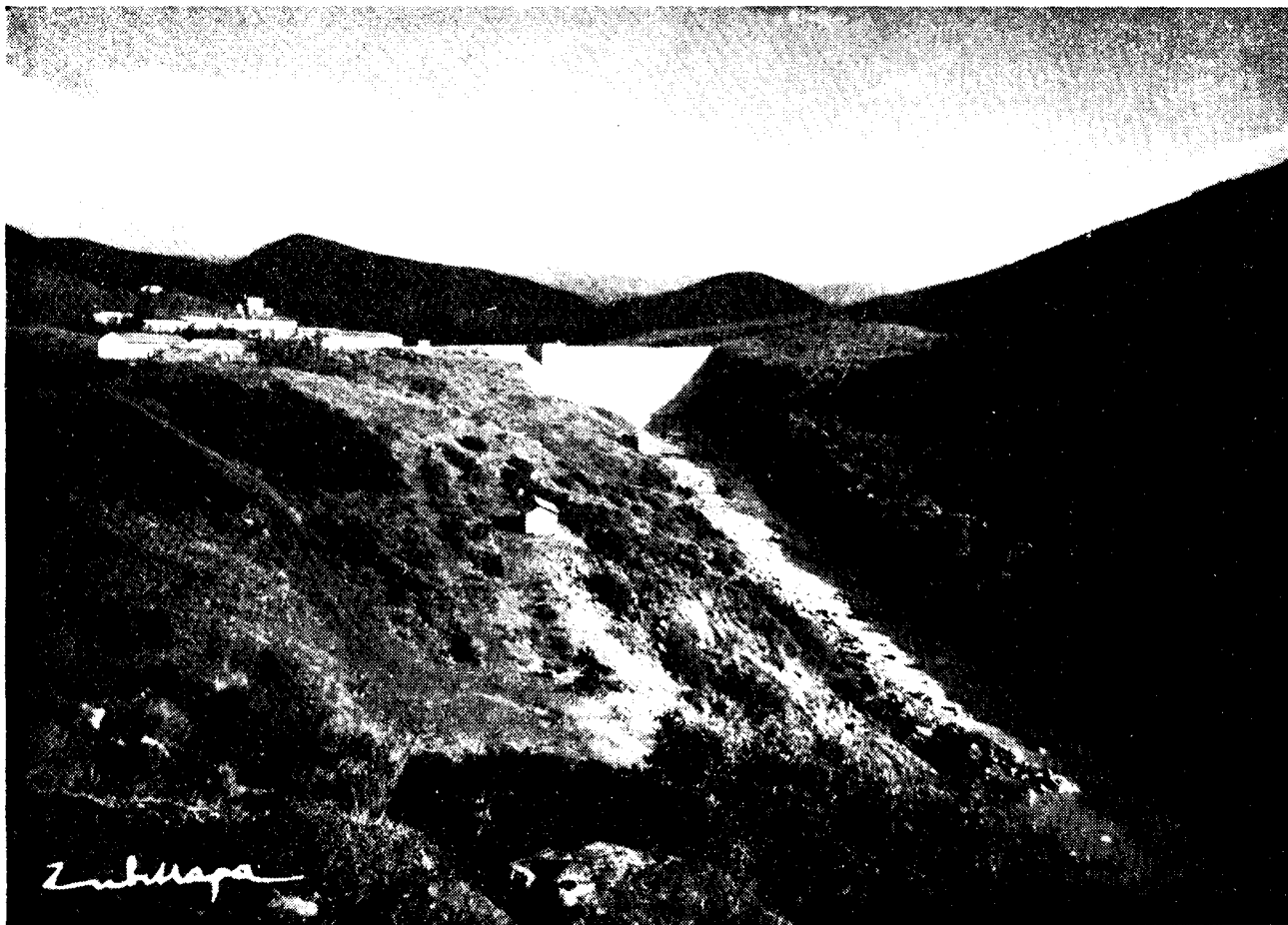
Barrage du Nakhta. Vue générale prise de l'aval
