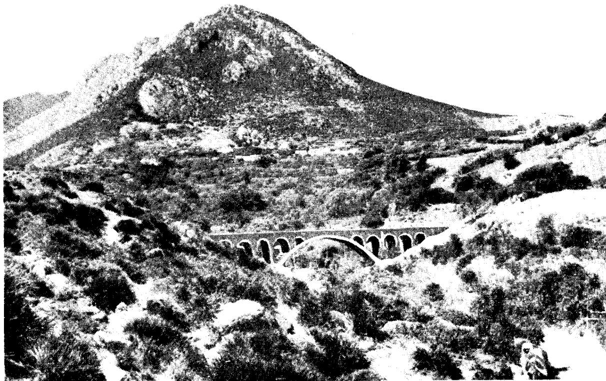
Canal de Nakhla. Aqueduc de traversée de l'oued Bou Zentat
