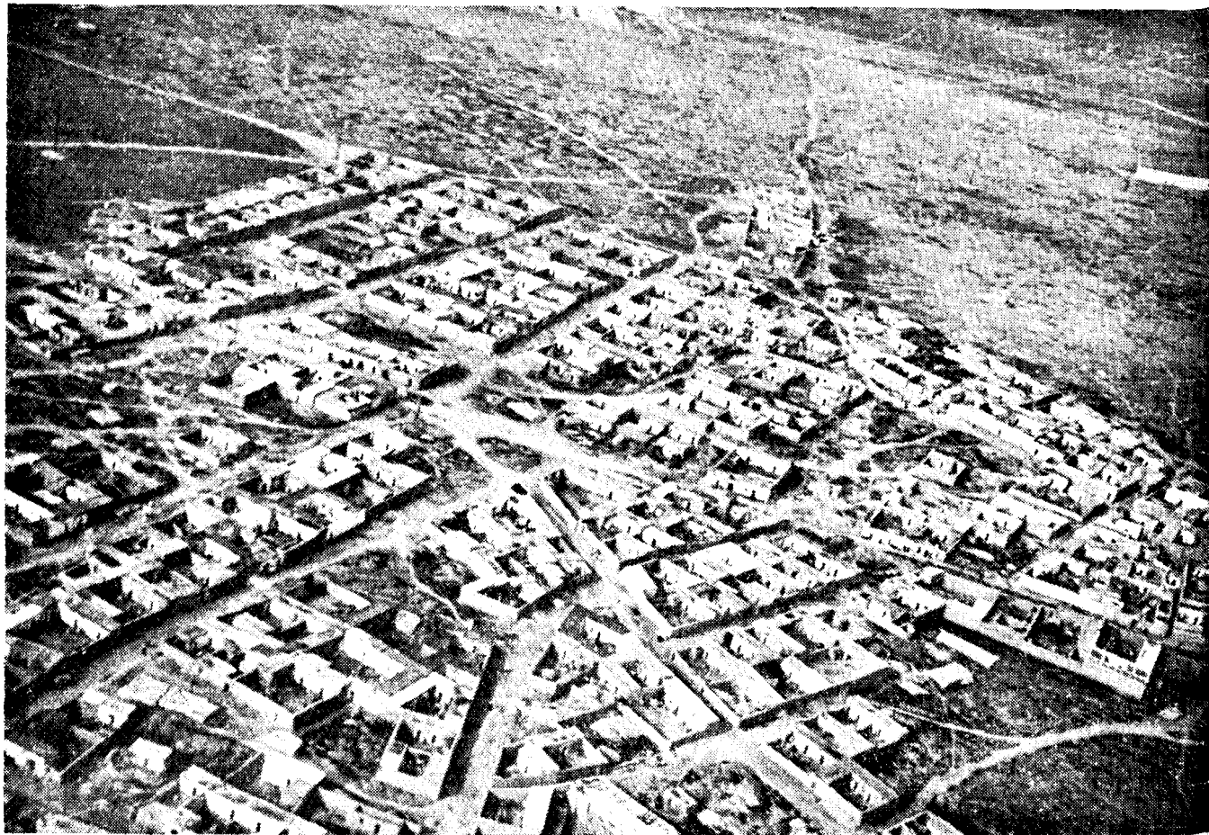
Un village périphérique, le village de Koulouch au Nord d'Oujda (Photo Service de l'Urbanisme au Maroc)
