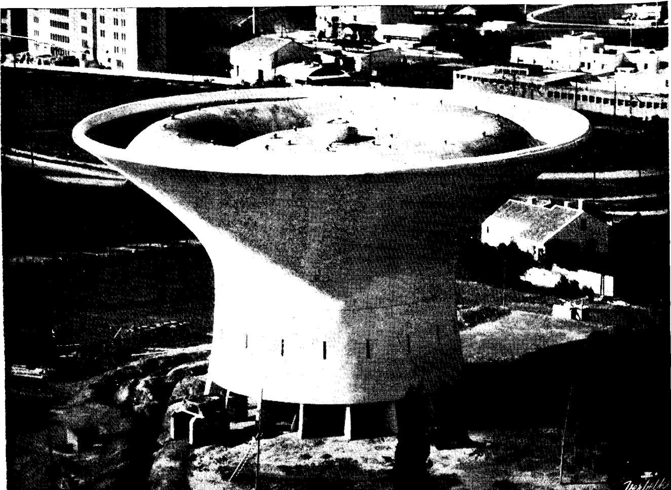
Le Réservoir de Fédala - Vue aérienne
